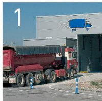
1 Entrada a la instalación.
